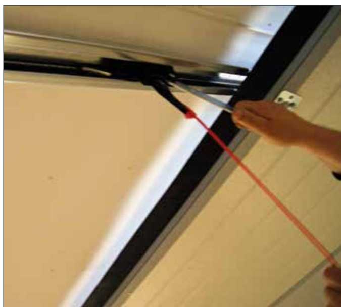
Løft porten manuelt opp så vogna tar tak i skjøten, før motor programmeres.
