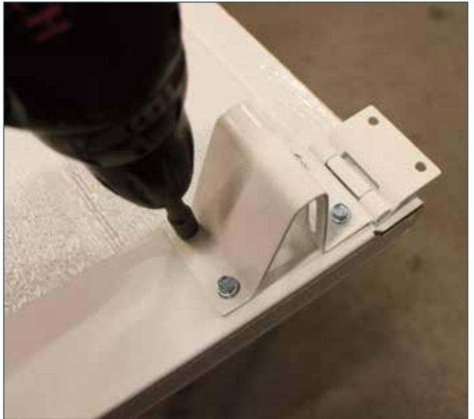
Monter sidehengsel som vist på bildet.
