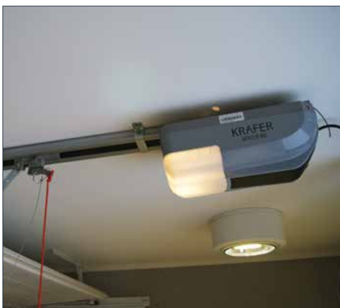
Ferdig montert motor.
